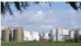
CHEMISCHE FABRIK WIBARCO GmbH Ibbenbüren
